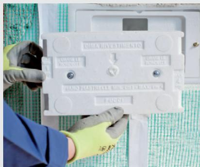
**6. INSERIRE** le leve 4/9 litri nelle asole della batteria di scarico, fissare lo sportello al corpo cassetta e apporvi la protezione in polistirolo.
