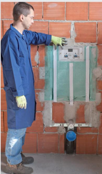
**3. POSIZIONARE** il telaio all'interno della parete, stendere la rete, tamponare i vuoti.
